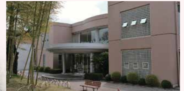
●2号館外観 センターホール、保健室や学生相談室があります。
